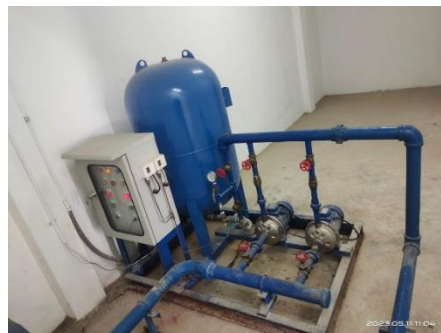
รูปที่ 43 booster pump
