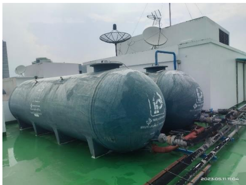
รูปที่ 14 ถังสำรองน้ำชั้นดาดฟ้าและใต้ดิน
