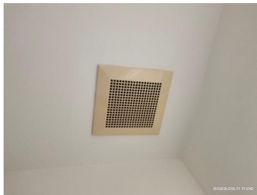
รูปที่ 38 พัดลมดูดอากาศ
