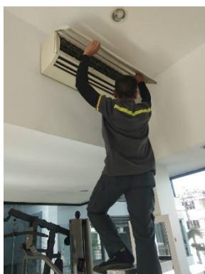
รูปที่ 17 เจ้าหน้าที่ล้างทำความสะอาด เครื่องปรับอากาศ
